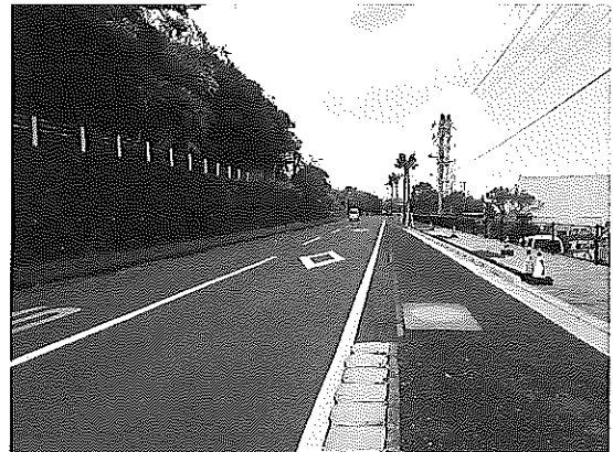
火力発電所前の道路拡幅工事
